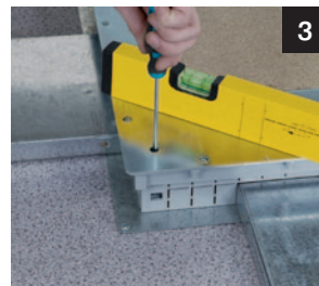
3 При помощи регулировочных винтов выставить уровень
