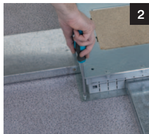
2 Закрепить коробку на полу
