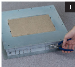
1 Завести в люк кабели, гофрированные трубы, лотки
