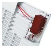
Вентилятор не работает - жалюзи ЗАКРЫТЫ
