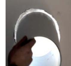
Вставьте телескопический корпус, предварительно отрегулировав его по ширине стены
